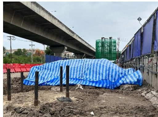
รูปที่ 2-19 การใช้ผ้าใบปิดคลุม กองดิน/ กองเศษวัสดุ
