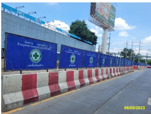
รูปที่ 2-14 การติดตั้งกำแพงคอนกรีต พร้อมรั้วผ้าใบทึบ ความสูง 2.0 เมตร
