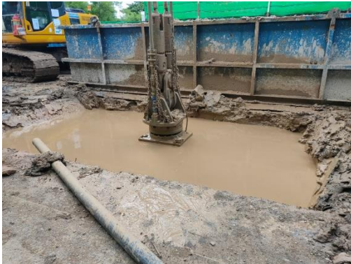
เสาเข็มเจาะหน้าตัดเหลี่ยม (Barrette Pile)
