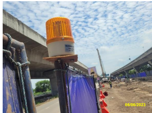
รูปที่ 2-32 การติดตั้งไฟกะพริบ
