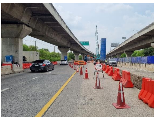
รูปที่ 2-38 การตีช่องจราจร และการจัดระยะสอบ
