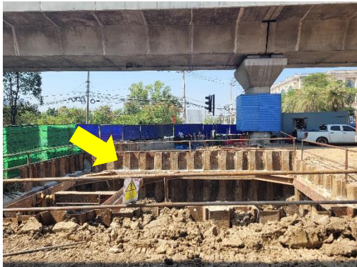
รูปที่ 2-4 การตอกเข็มพืด (Steel Sheet Pile)
